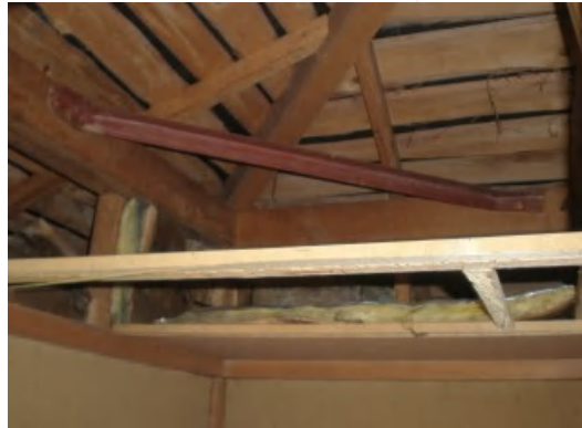
写真 15 アンクル材による火打ち
