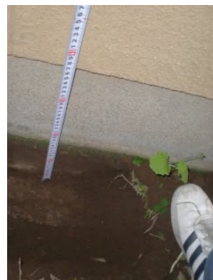
写真 23 基礎掘り起こし
