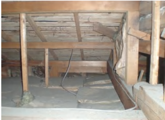
写真 14 小屋裏天井面の様子
