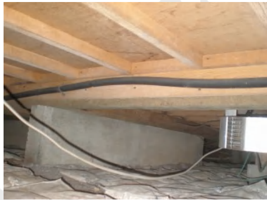
写真 19 台所床下の様子
