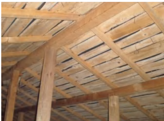
写真 16 小屋裏野地面の様子
