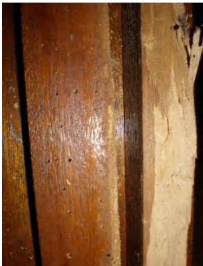
左が虫穴、右がケーシング内部の様子 (所有者確認の上解体確認)
